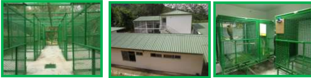
Adecuaciones de instalaciones en el nuevo CAV-CEARFS
