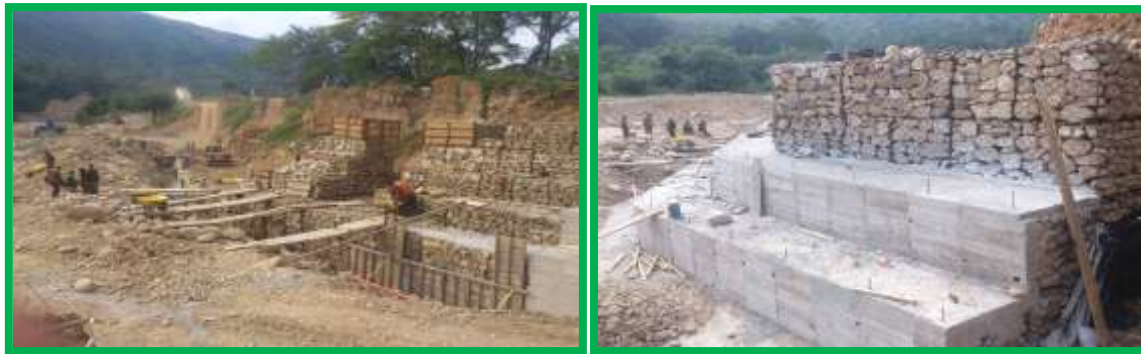
Construcción obras de Control de Cauce Parque Industrial
