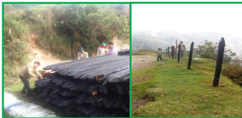
Figura 9. Insumos, Inmunización de Postes e Hincado
