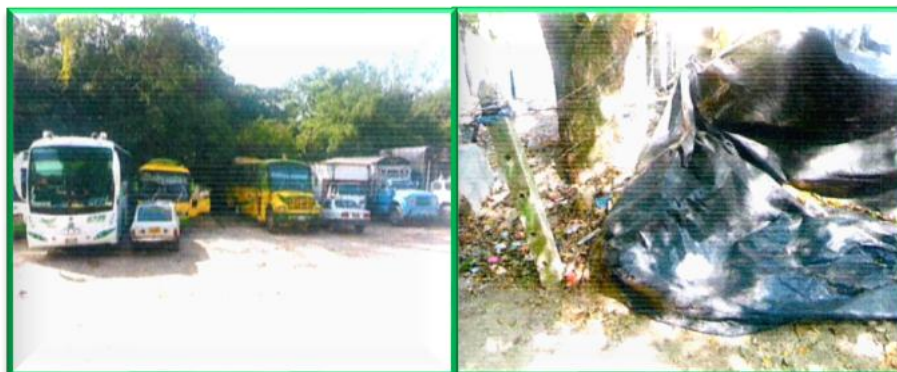
Figura 29. Antes sector del Barrio Zapamanga V Etapa, Floridablanca, recuperado y aislado con cerca en malla eslabonada y postes de concreto
