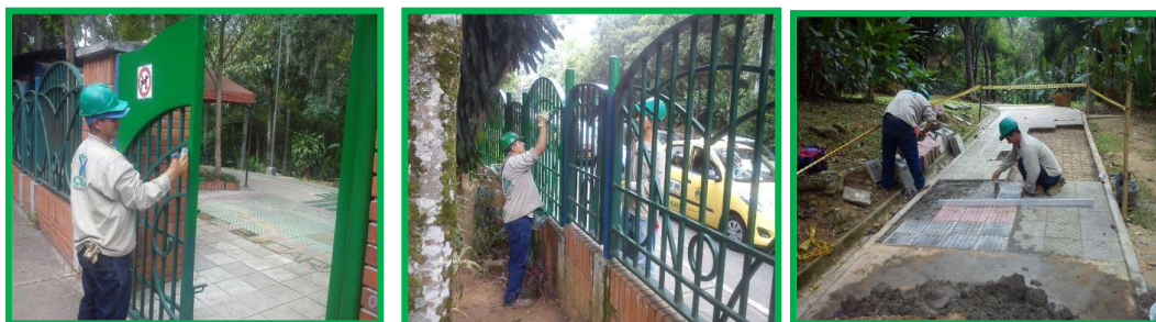
Figura 33. Mantenimiento y adecuaciones realizadas en el Parque Escuela Ecológica la Flora correspondiente a los cambios de lozas en los senderos, arreglo de puertas, rejas y pintura de las mismas.
