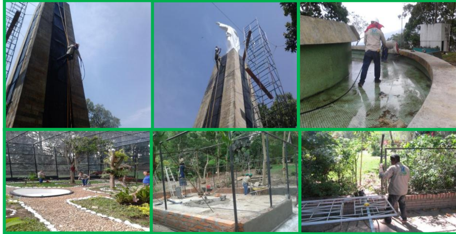
Figura 34. Registro Fotográfico de los trabajos en el Jardín Botánico Eloy Valenzuela los cuales corresponden al arreglo del cerramiento perimetral, construcción de un vivero y construcción del aviario.
