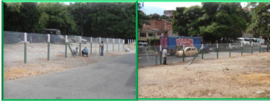
Figura 30. Después sector del Barrio Zapamanga V Etapa, Floridablanca, recuperado y aislado con cerca en malla eslabonada y postes de concreto
